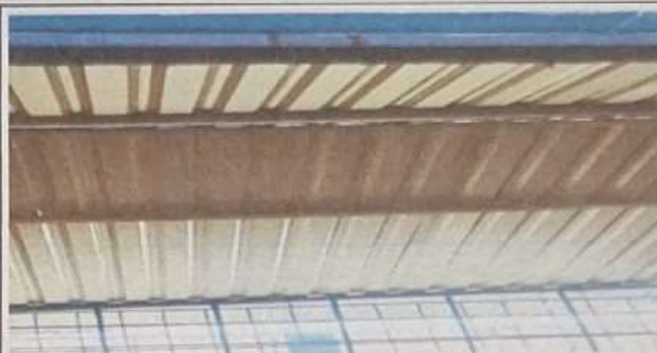
Foto 2: Sustitución de capote de lámina a capote troquelada, aula ubicada en el módulo 2 del establecimiento
